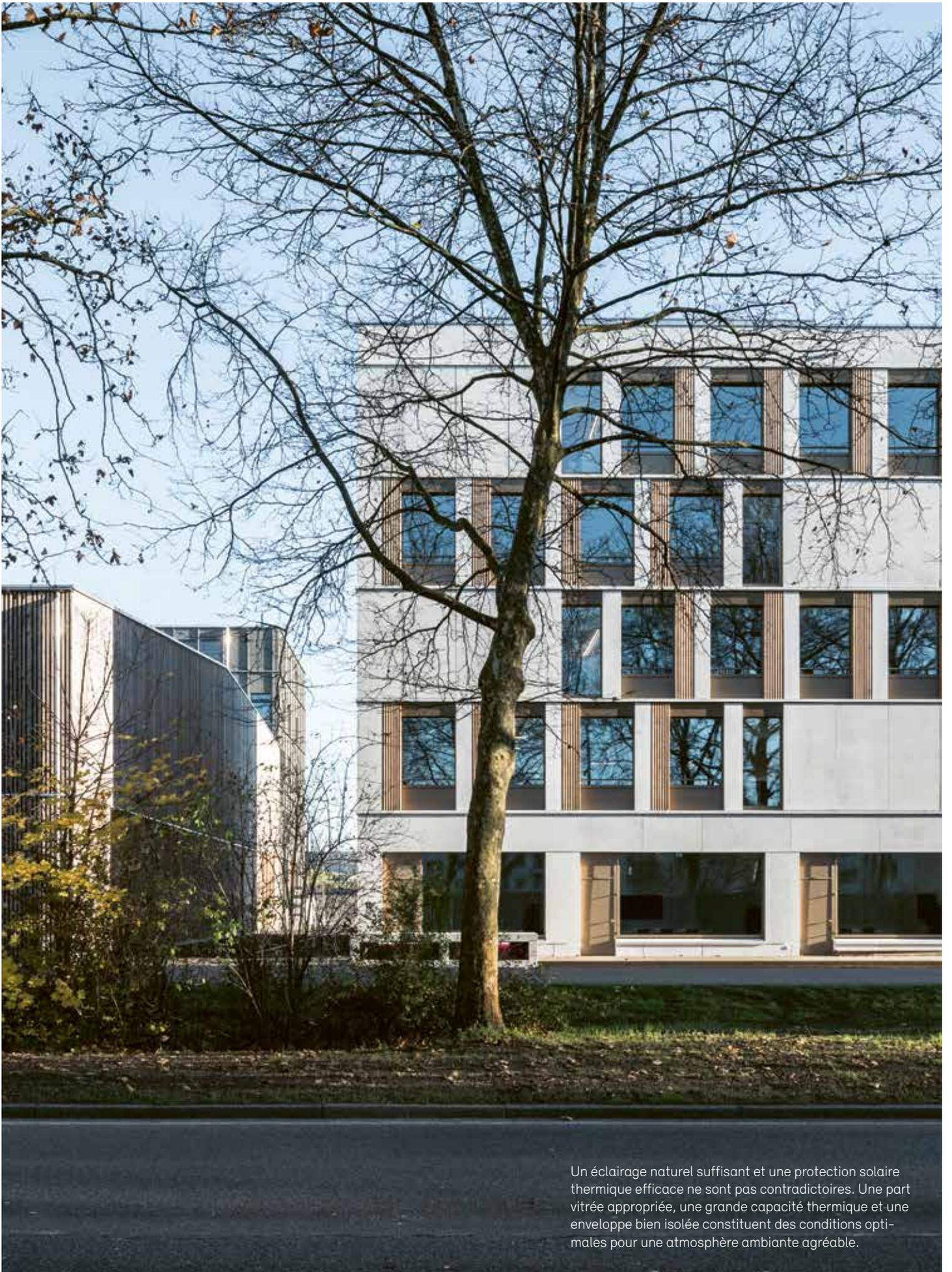
Un éclairage naturel suffisant et une protection solaire thermique efficace ne sont pas contradictoires. Une part vitrée appropriée, une grande capacité thermique et une enveloppe bien isolée constituent des conditions optimales pour une atmosphère ambiante agréable.
