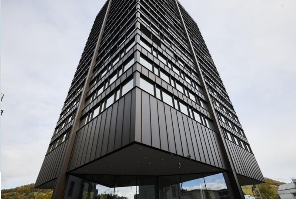
**Markant ist die Fassade aus goldbraunen Aluminium-Blechpaneelen.**
